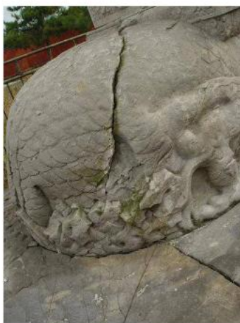
照片 A11 结构裂隙
