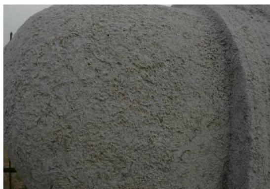
照片 A10 表面溶蚀
