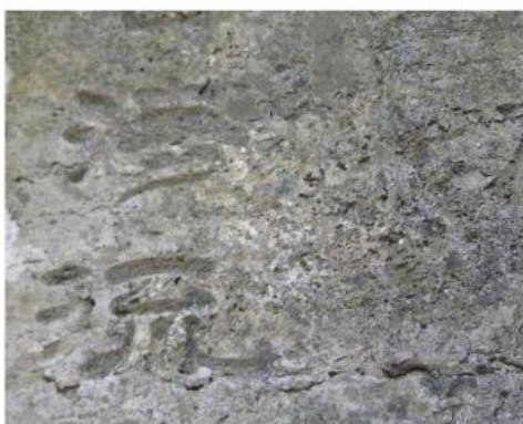
照片 A9 表面坑窝状溶蚀
