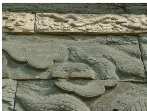
照片 A7 表层层片状剥落
